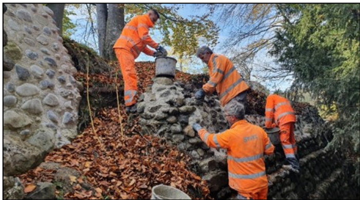
Die letzten Mauern wurden durch Facharbeiter und Lehrlinge der Firma Stutz AG saniert.
