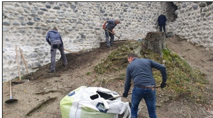
Freiwillige haben mehr als 500 Einsatzstunden geleistet. Dadurch konnten Kosten gespart werden.
